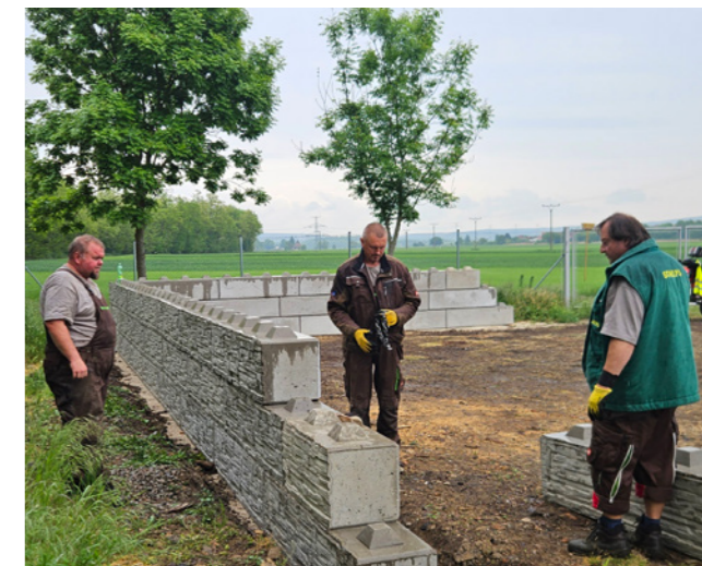
Stavba opěrné zdi ve sběrném dvoře.
