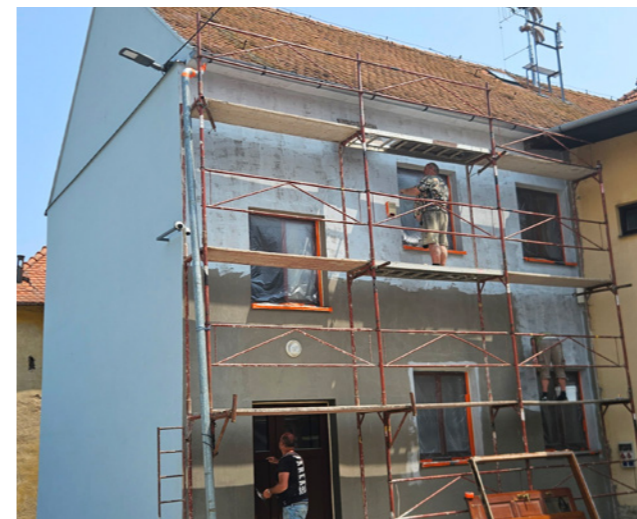
Práce na nové fasádě budovy radnice.
