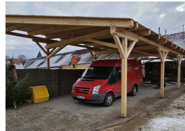
Přístřešek pro obecní techniku
