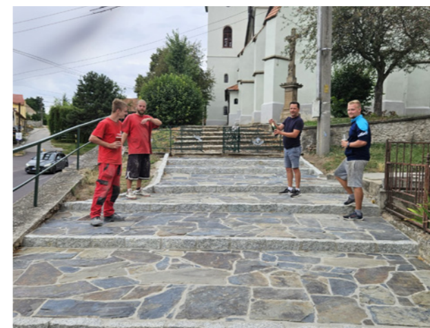
Schodiště ke kostelu
